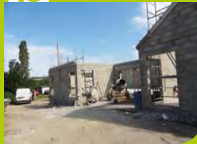
Le futur cabinet médical en construction
