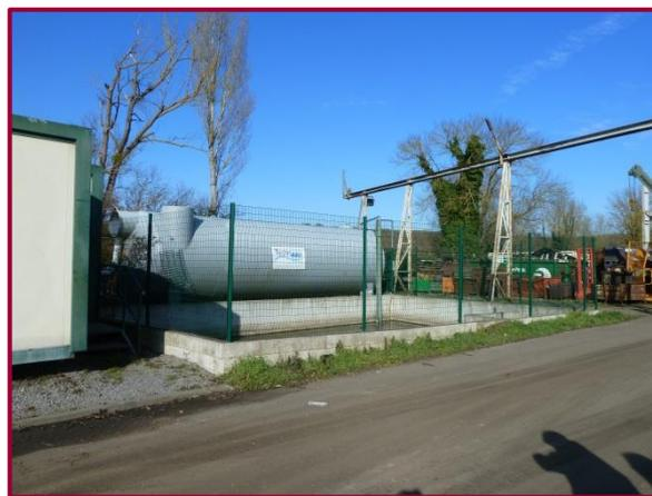
*Vue sur le bassin de récupération des eaux pluviales et du décanteur-déshuileur*
