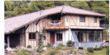
colombage châtaignier et remplissage briques de terre crue comprimée.
